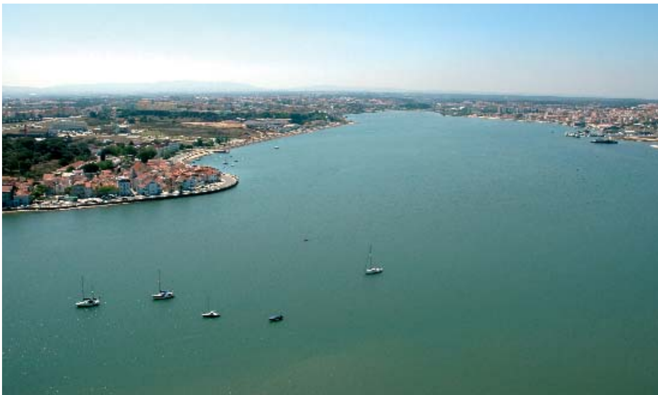
Vista aérea do Núcleo Urbano Antigo do Seixal e parte da Baía © CMS - António Silva, 2003
