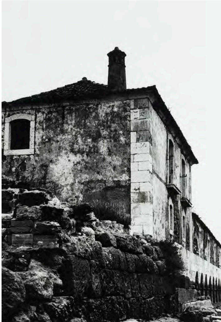
Moinho de Maré da Torre, Seixal
