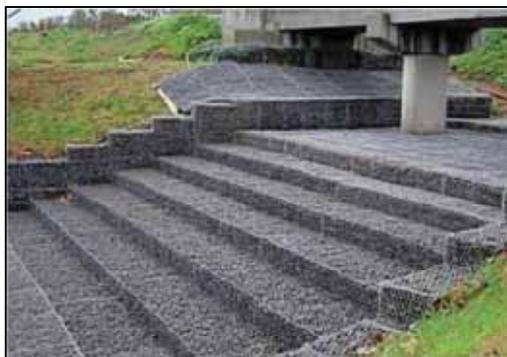
Figura 25 - Exemplo de dispositivo de entrada
